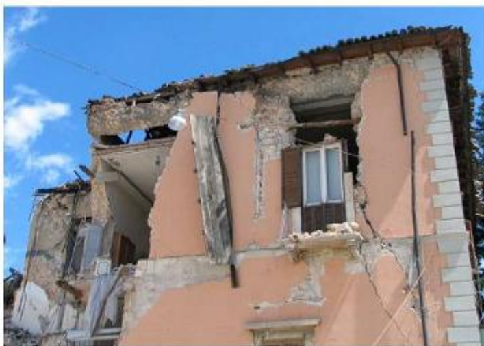
Figura 14 – Abruzzo 2009 – Danneggiamento di muratura in presenza di cordoli in c.a. (fonte: Governare il rischio 2012)
