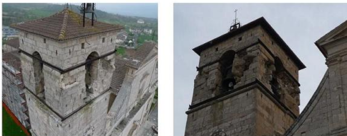
Figura 16 – Esempio di cerchiatura con elementi metallici (Abruzzo 2009)
