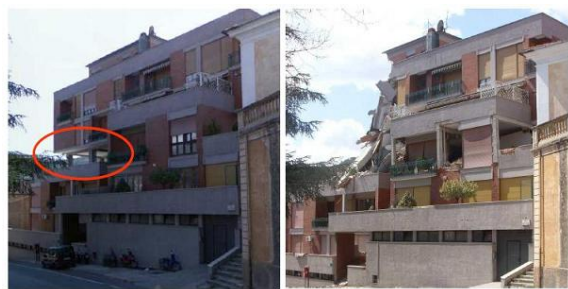
Figura 9 – Esempio di collasso dovuto a cedimento di piano “soffice” - L'Aquila, 2009
