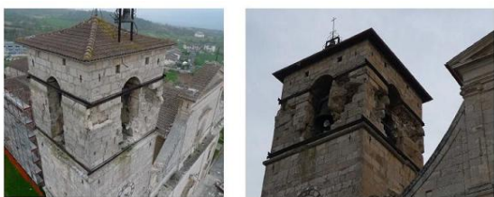
Figura 16 – Esempio di cerchiatura con elementi metallici (Abruzzo 2009)
